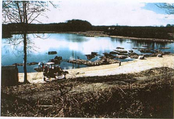
Vassblocken vinschas in till stranden. Tekniken förbättrades när vinscherna gick sönder p g a de tunga vassblocken
