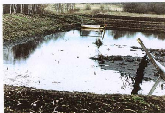
Pumpningen av sediment har börjat. Avrinningen sker över natten.
