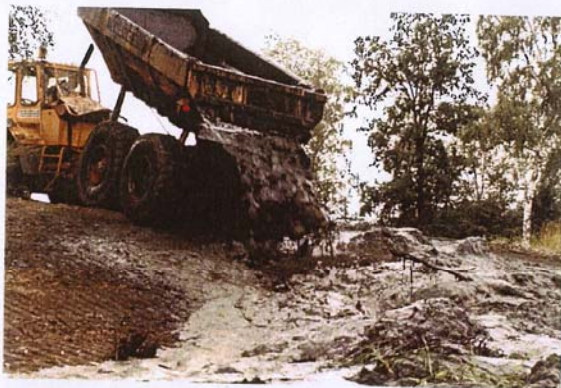
Dyn och vassrötter placeras i nya sedimenteringsdammen
