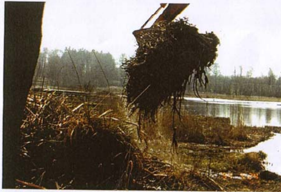
För att kunna hantera de stora massorna av flytvass drogs endast 2.000 m 2 in för uppgrävning och avrinning
